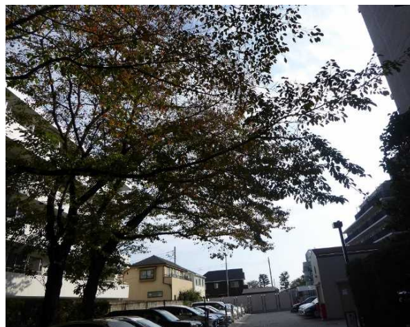
・下枝が車にあたり、その部分の枝枯れと落下の危険がある剪定前の状況。
