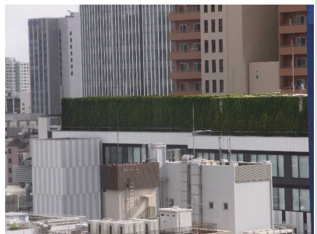
・周辺の景観とメンテを考慮したヤシマット併用金網補助資材使用の設備機器ヤードの壁面緑化
