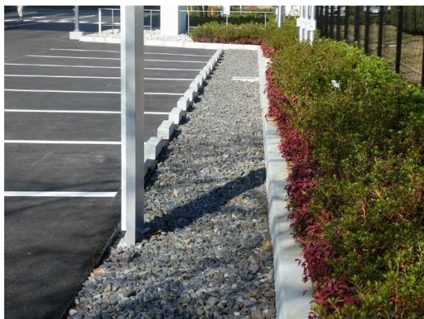
・車止め後部を浸透レンチ敷設の砂利敷の駐車場
