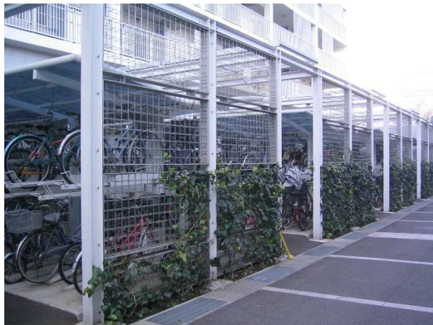
・金網補助資材使用の駐輪場の壁面緑化
