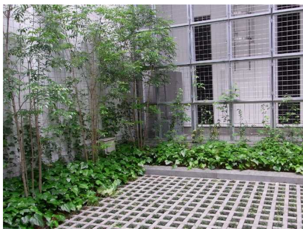
・タマリユウのコンクリートブロック製の透水性芝生舗装にした緊急用の駐車場
