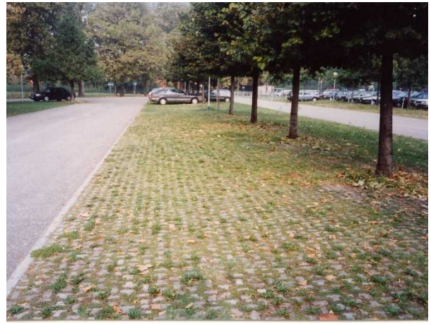
・コンクリートブロック製透水性芝生舗装の駐車場
