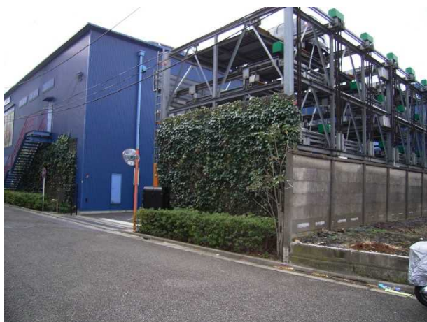
・ヤシマット併用金網補助使用を使用した立体駐車場の壁面緑化
