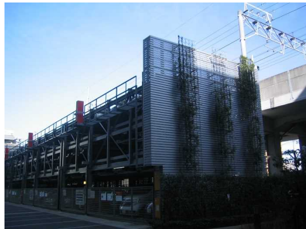
・金網補助資材使用の立体駐車場の壁面緑化
