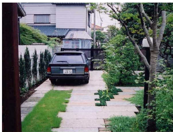
・個人住宅の車が乗り入れない部分を緑化した縦列駐車場
