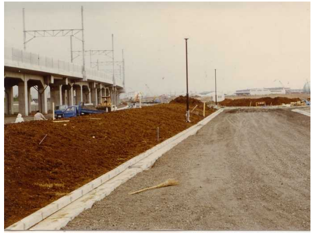
・植栽基盤の造成(海岸埋立地)
