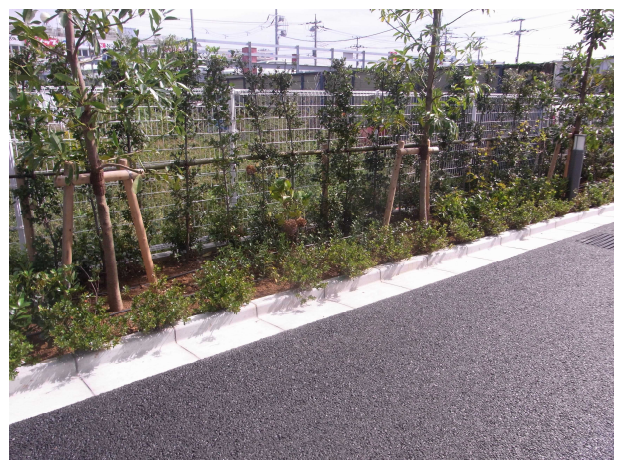
・葉張りが足りない生垣の竣工時の状態
