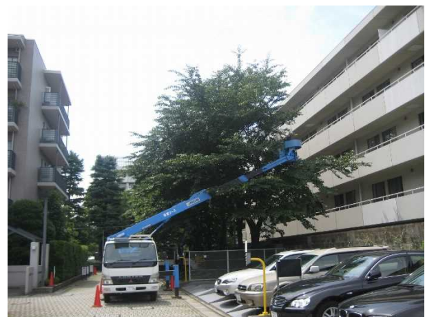
・高所作業車によるサクラの剪定
