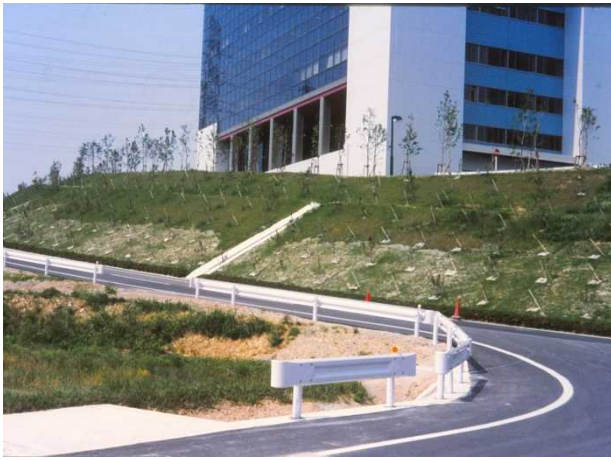
・1mの苗木植栽に法面緑化
