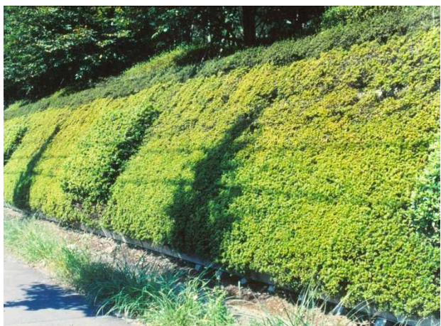
・擁壁専用の緑化ブロックを使用した緑化
