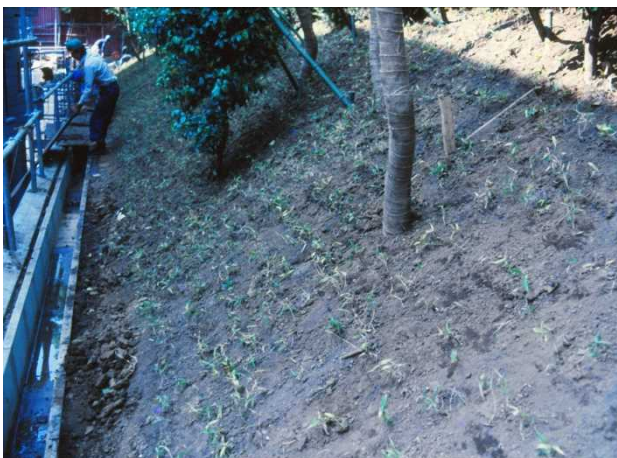
・30度の勾配での法面植栽
