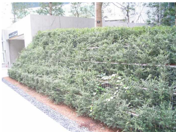
・溶接金網カゴを使用した法面植栽
