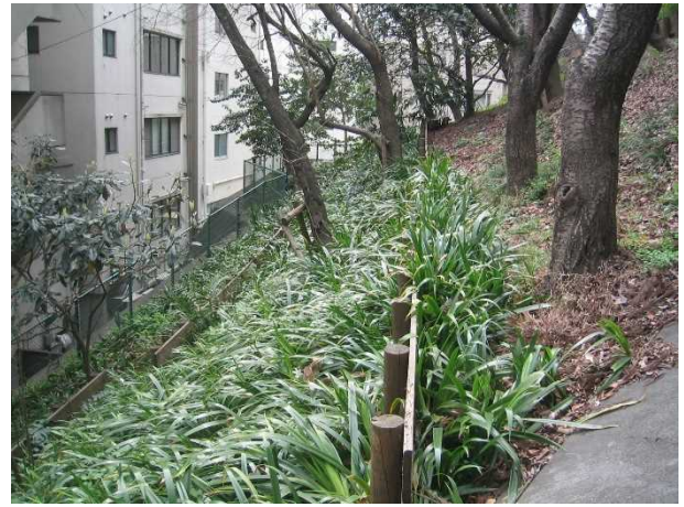
・土留め材の仕様の法面植栽
