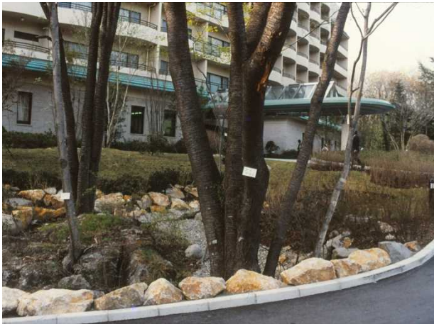
・現地発生材使用の土留め使用の法面植栽
