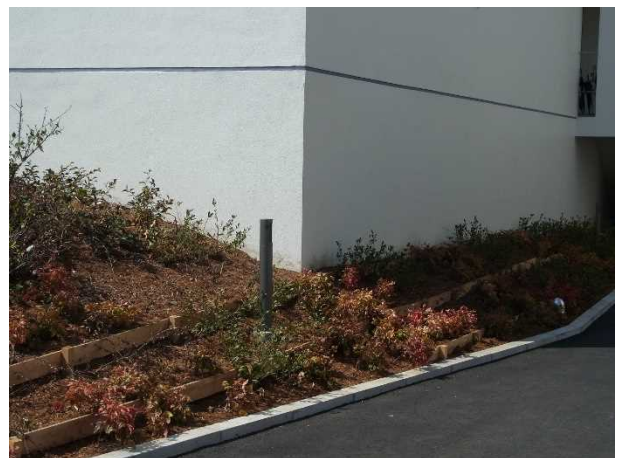
・土砂流出防止のための簡易土留め材の設置
