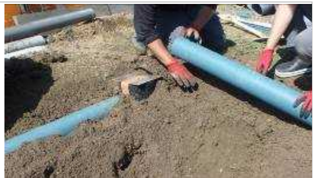
・くるくるストップ通気・透水管の敷設
