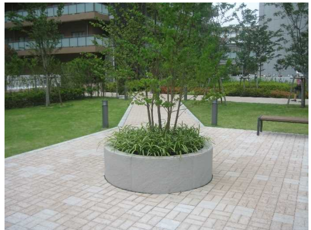
・植栽基盤の最大化と根腐れ防止のために基礎不要 のTLC 緑化パネルを使用しての植栽
