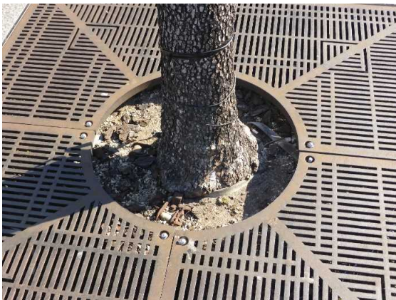
・地下支柱の食い込みによる枯れ
