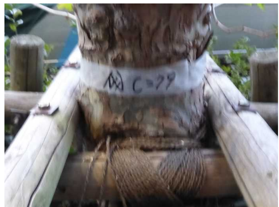
・樹木に生育を阻害している支柱
