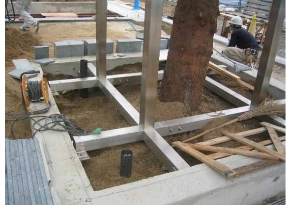
・角パイプ支柱
