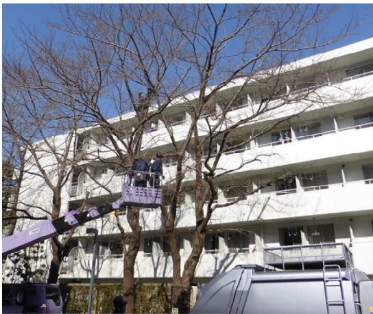
・高所作業車を使用した剪定
