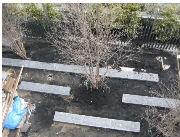
・設備の配管との調整での植栽樹木の位置決め
