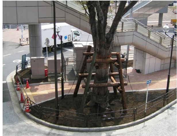
・移植のケヤキの大木と井桁支柱
