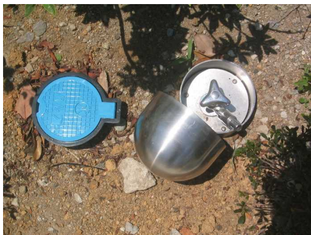
・立型散水栓ボックス
