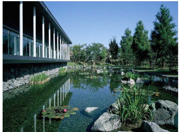
・池底は砂利敷で護岸は蛇籠を使用して調整池機能のあるビオトープの池(2016年ビオトープ大賞受賞)
